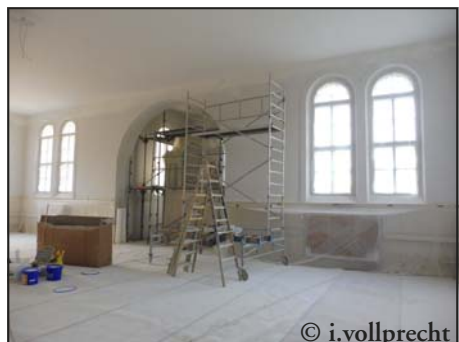
Malergerüst im Kleinen Saal
