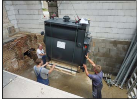
Aufstellen des Dampfkessels im Heizhaus
